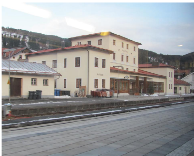
Рис. 1. Вокзал Шлірзее. Верхня Баварія
