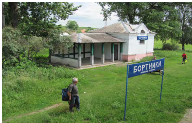
Рис. 41. Будівля станції Бортники
