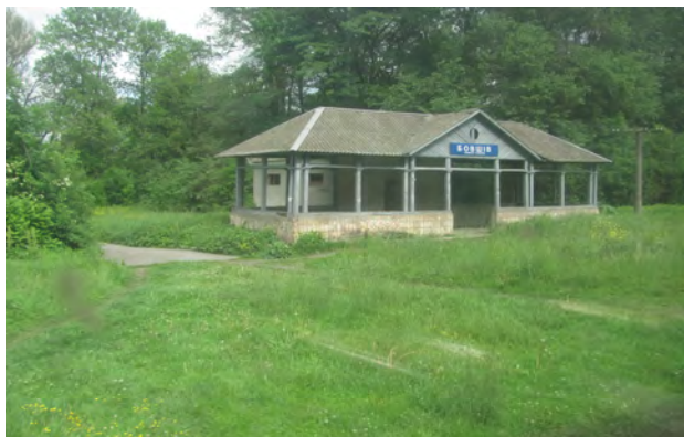
Рис. 40. Будівля станції Бовшів
