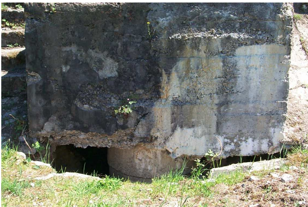
Рис.3. Результати руйнування підпірної стінки дросельного затвору.
