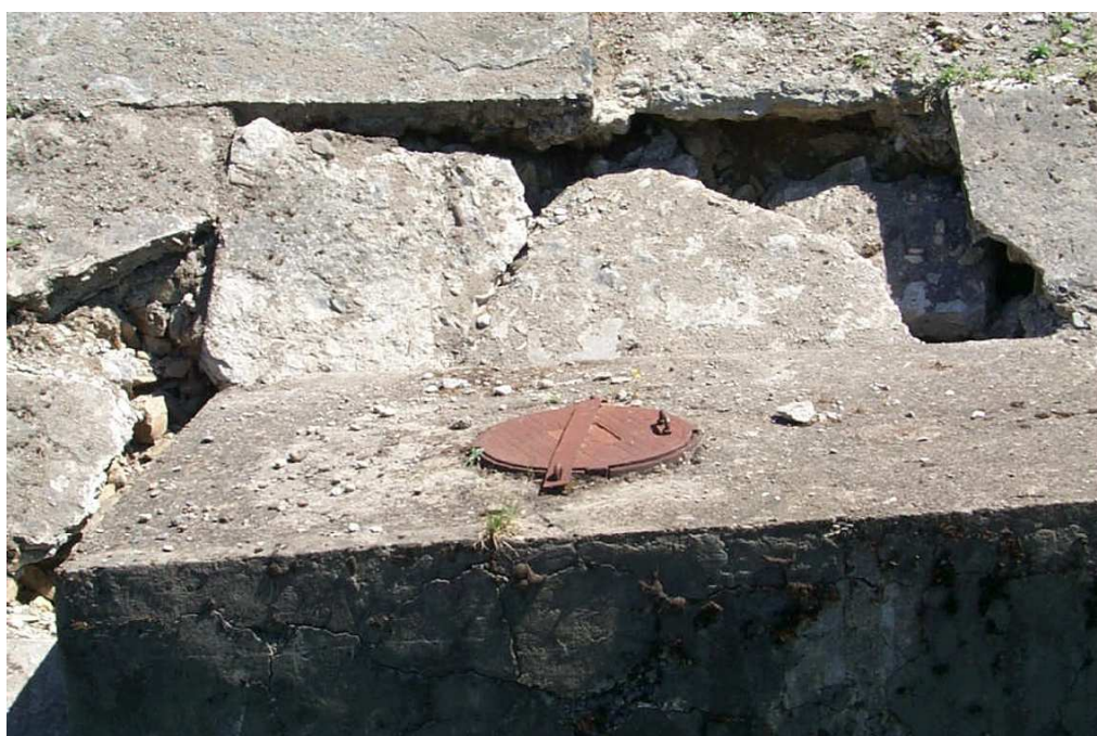
Рис.4. Утворені пустоти в тілі підпірної стінки.
