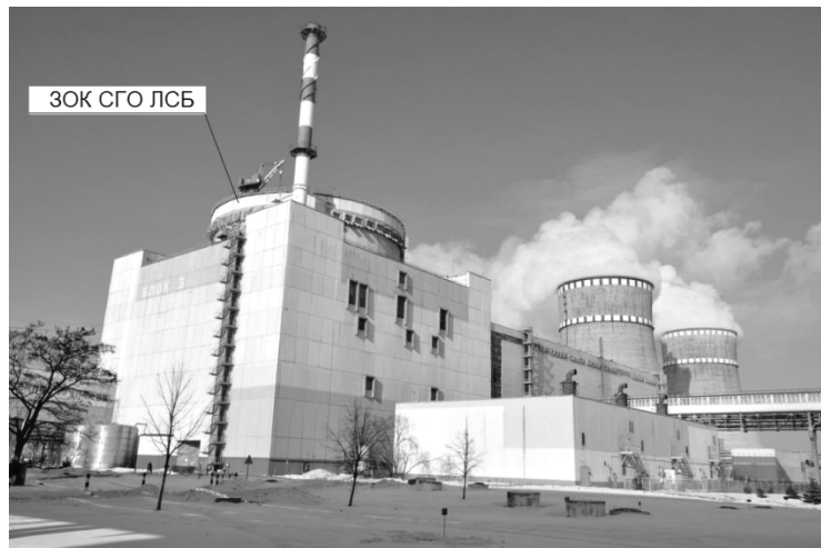
Рис. 1. Загальний вигляд енергоблоку №3 на Рівненській АЕС
