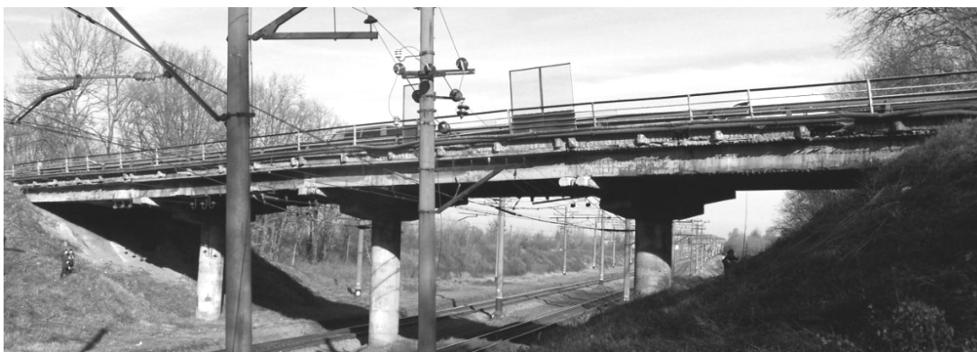
Рис. 1. Загальний вид існуючого шляхопроводу
