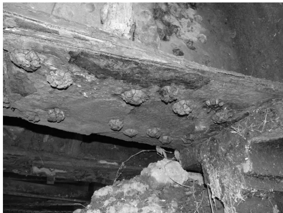
Рис. 4. Значна корозія металу з ослабленням усіх елементів
