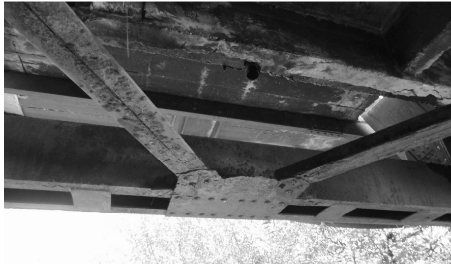
Рис. 2. Значна корозія балкової клітки і з'єднань
