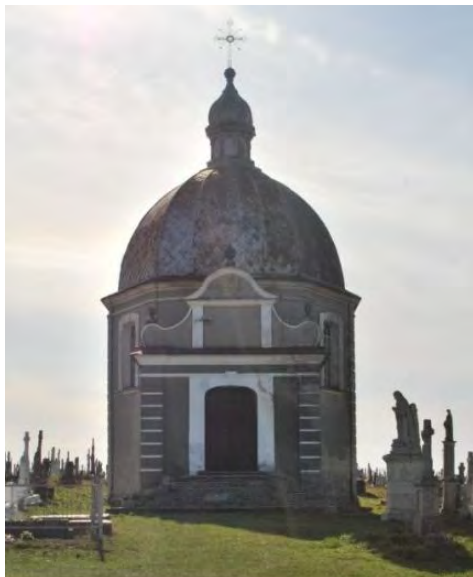
Рис. 10. Цвинтарна каплиця в Підкамені Чільний фасад. Фото автора, 2014 р.
