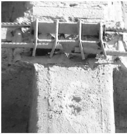
Рис. 4. Процес виконання підсилення горизонтальних ребер панелей: а – закріплення кільцевої арматури на підсиленних закладних деталях панелей; б – між закладними деталями попередньо напружені арматурні стрижні поєднані між собою хомутами та зафіксовані до існуючої арматури горизонтальних ребер
