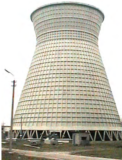
Рис. 5. Збірна залізобетонна градирня Дарницької ТЕЦ після реконструкції
