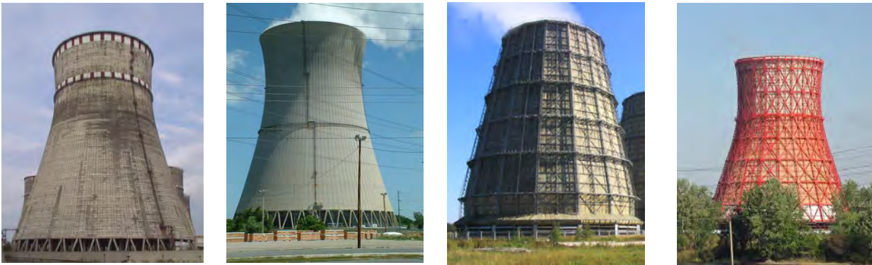
Рис. 1. Баштові градирні: а – залізобетонні; б – металеві
