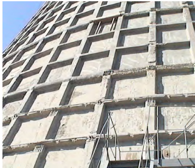
Рис. 6. Зовнішня поверхня оболонки градирні під час її ремонту та підсилення попередньо напруженими арматурними стрижнями в межах додаткових горизонтальних ребер жорсткості
