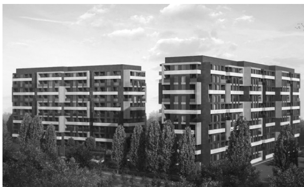
Рис. 9. ЖК "Avalon Garden", вул. Порохова, 20 [6]
