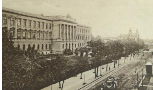
Трансформаторна підстанція навпроти головного корпусу Львівської політехніки
